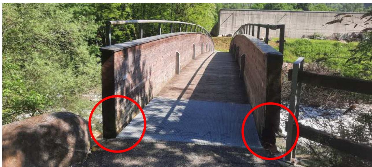
Foto 2: dettaglio ponte esistente
