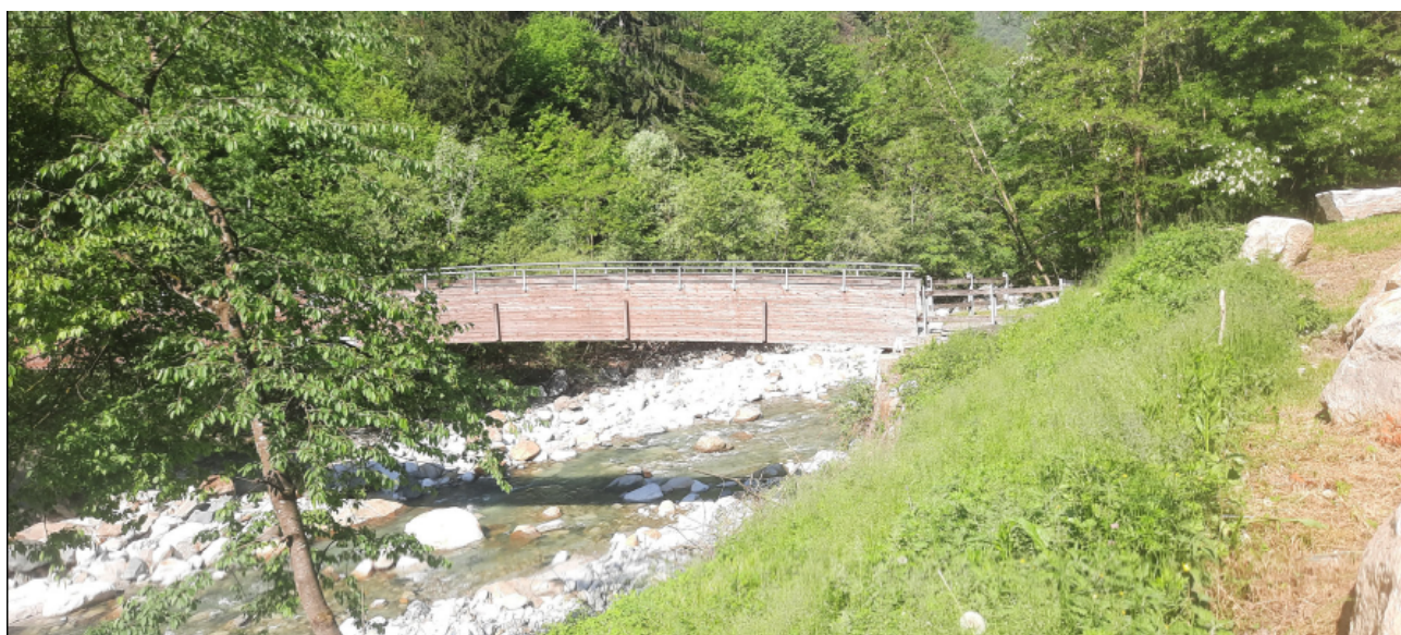
Foto 1: panoramica ponte esistente
